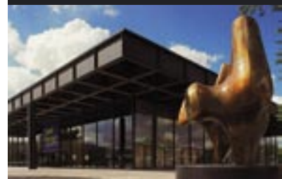
Nationalgalerie di M. v. Rohe
